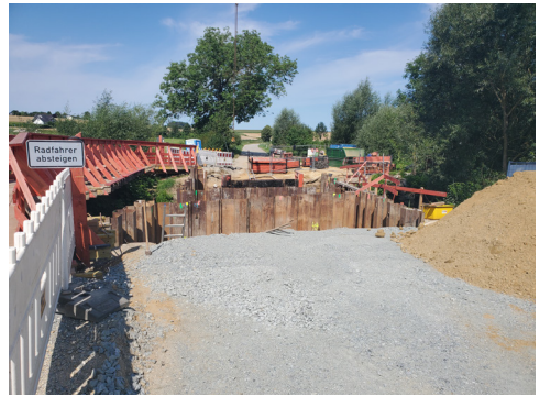
Baustelle des Brücken-Ersatzneubaus bei Höglendorf
