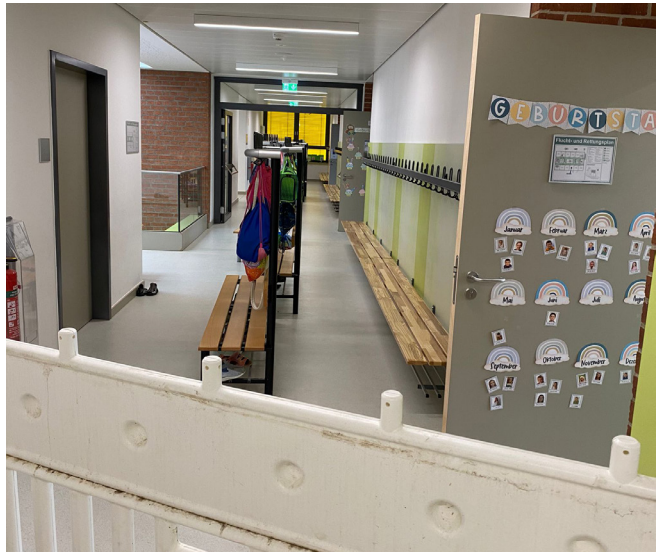
Der letzte Sanierungsabschnitt an der Schule steht kurz vor der Fertigstellung
