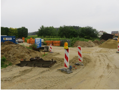
Erschließung des Baugebiets „Am Wanderweg“ in Unterlauterbach
